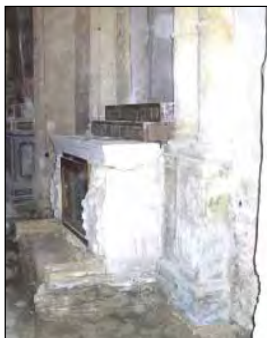
Le foto riportate in sequenza documentano lo stato di degrado dell'altare di S. Diego prima dei lavori di restauro, con la mensa posticcia ed i due gradi lignei assenblati con materiali di recupero dell'originaria cornice della tela del Catalano.
