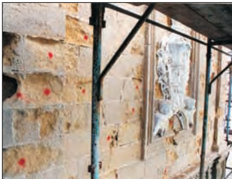
In alto la facciata dopo l'intervento di risanamento e restauro. In basso particolare dei conci degradati da ricostituire con la tecnica del cuci-scuci.
