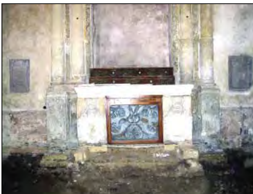
Le foto riportate in sequenza documentano lo stato di degrado dell'altare di S. Diego prima dei lavori di restauro, con la mensa posticcia ed i due gradi lignei assenblati con materiali di recupero dell'originaria cornice della tela del Catalano.
