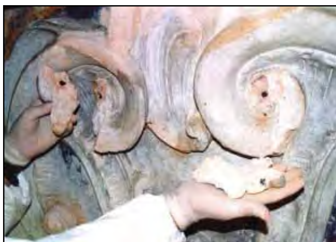
Sulla destra il cappellone prima dei restauri. In alto particolari degli stucchi e fasi del restauro
