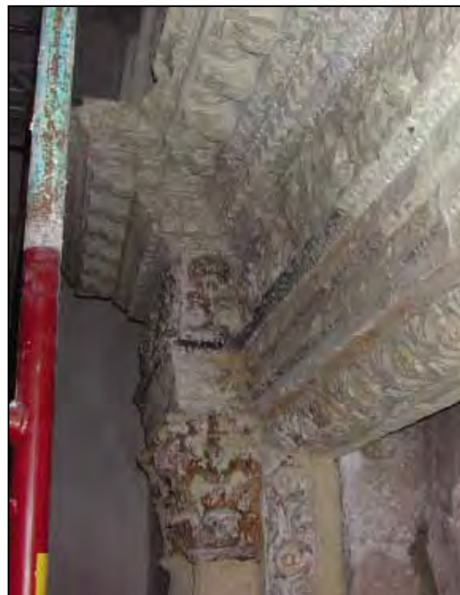
Le foto riportate in sequenza documentano lo stato di degrado dell'altare di S. Diego prima dei lavori di restauro, con la mensa posticcia ed i due gradi lignei assenblati con materiali di recupero dell'originaria cornice della tela del Catalano.
