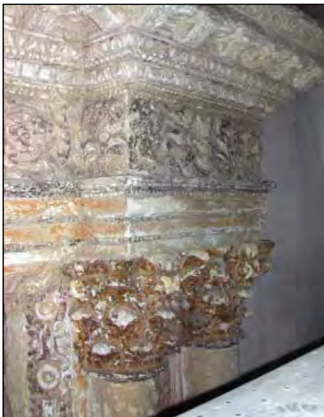
Le foto riportate in sequenza documentano lo stato di degrado dell'altare di S. Diego prima dei lavori di restauro, con la mensa posticcia ed i due gradi lignei assenblati con materiali di recupero dell'originaria cornice della tela del Catalano.
