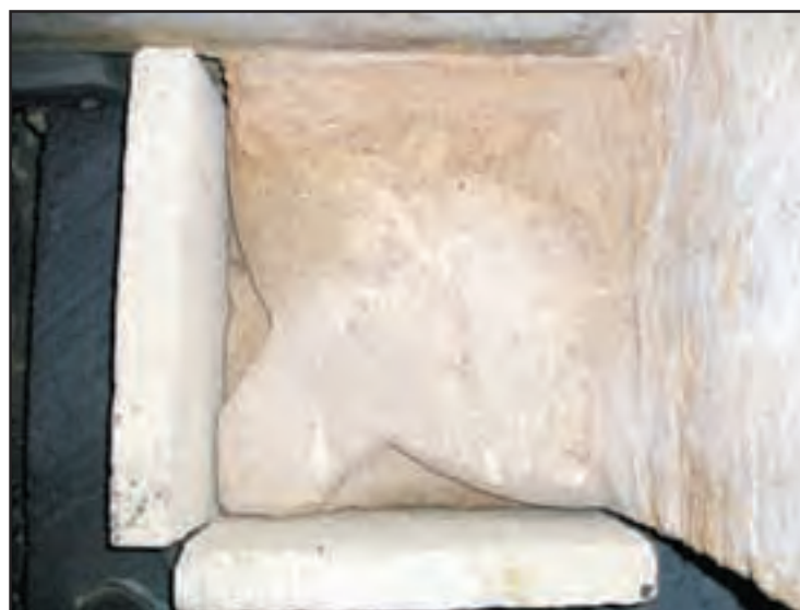
Basamento di una struttura del XV secolo a semicolonna e, in basso, tracce del capitello in pietra leccese resecato, probabilmente, nel XVIII secolo
